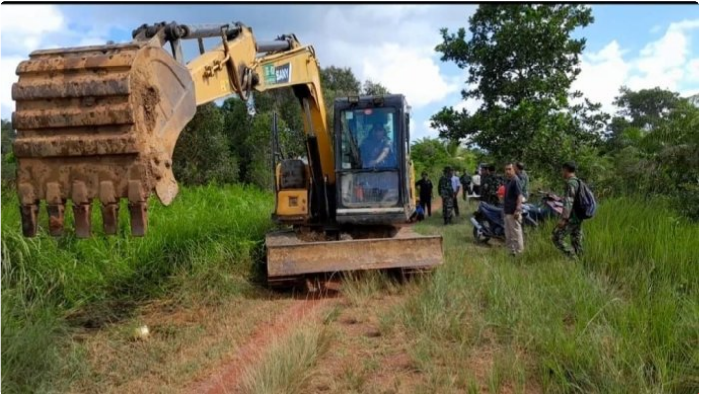
Dandim 1009/Tla, Turunkan Excavator Di Lokasi TMMD
