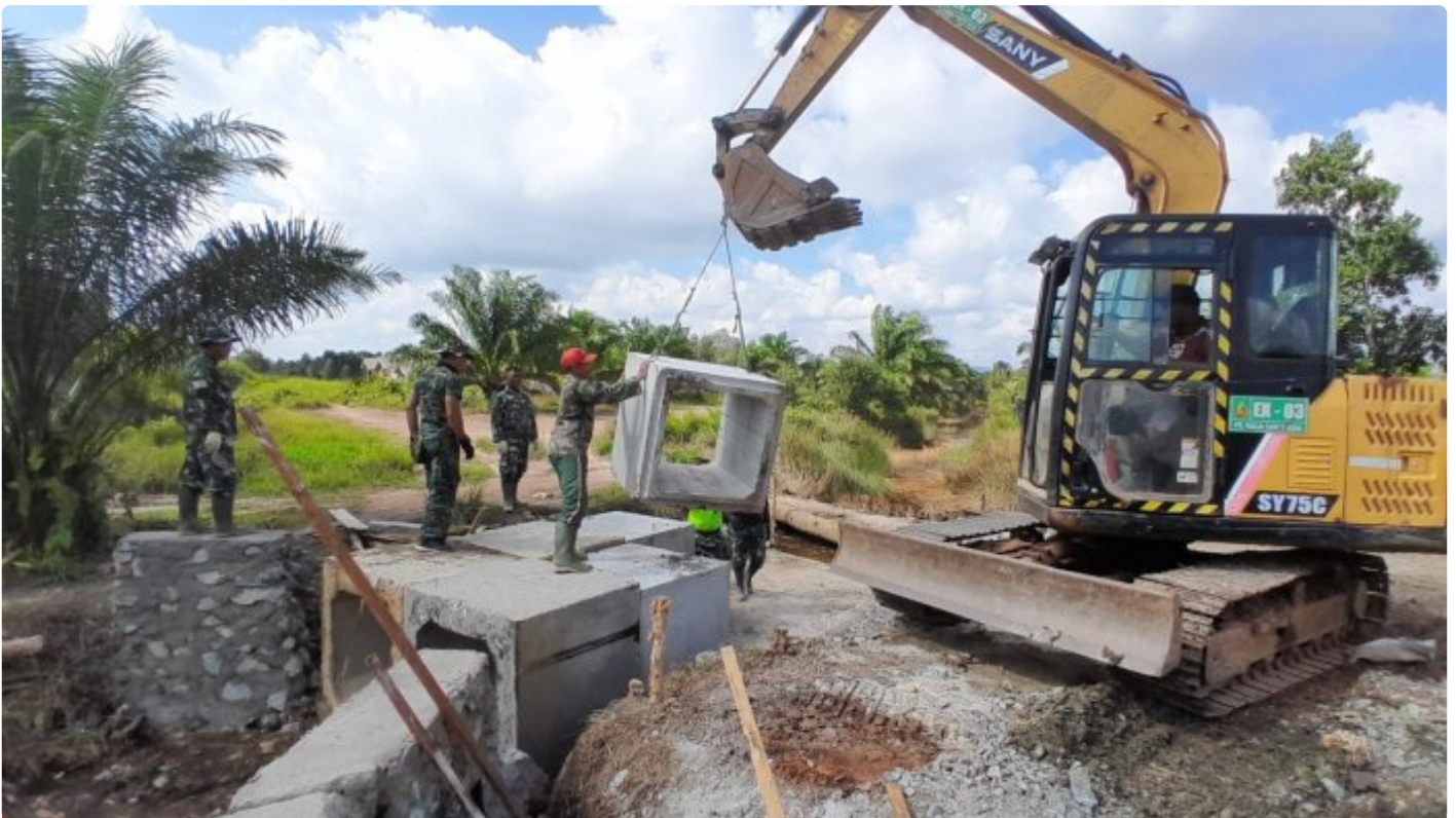
Box Culvert Jembatan Penghubung Desa Telaga Langsung Mulai Dipasang
